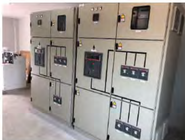
รูปที่ 25 ตำแหน่งอุปกรณ์ภายในตู้ควบคุมไฟฟ้ากระแสสลับ SDB (SOLAR DISTRIBUTION BOARD)
