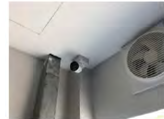
รูปที่ 34 การติดตั้งกล่องระบบ CCTV
